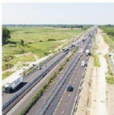
Lavori per la terza corsia in A4
