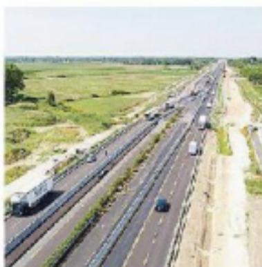
Lavori per la terza corsia in A4
