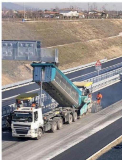
Un cantiere per la viabilità: la provincia di Macerata ha un gap infrastrutturale importante, è all'86esimo posto in Italia (foto d'archivio)
